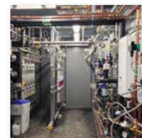
Reinigung im Inneren des Containers
